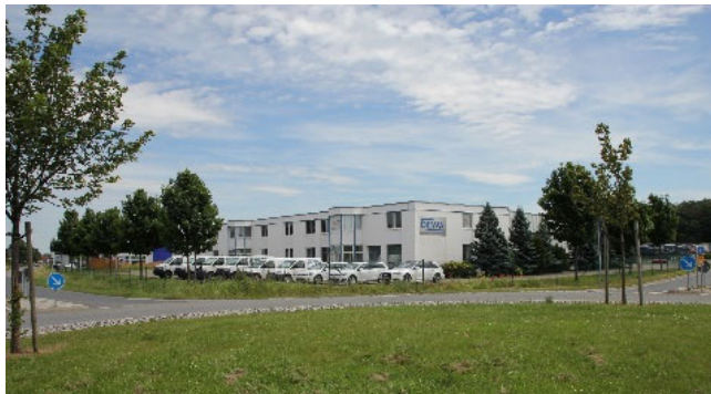
Blick auf die DEWA GmbH in Vienenburg Foto: DEWA Engineering und Anlagenbau GmbH
